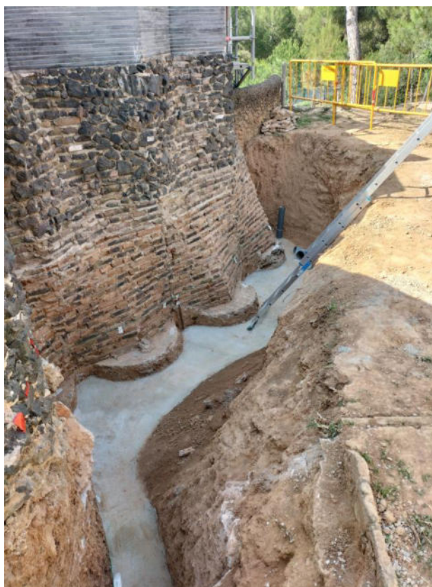
Imatge de la rasa del mur de la zona de la sagristia
