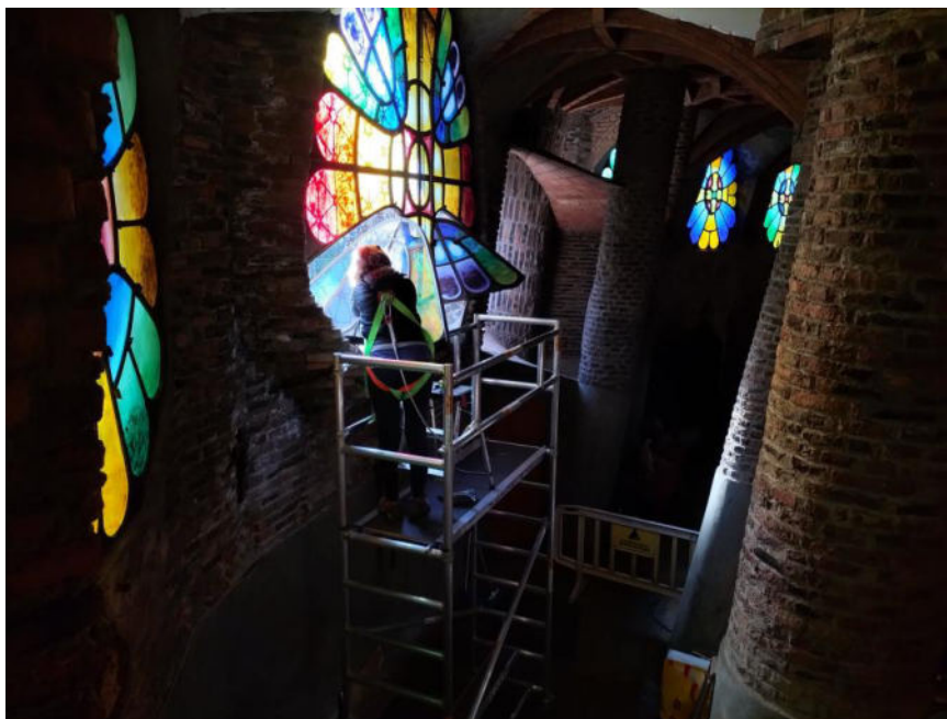
Imatge dels treballs de substitució dels vidres de la finestra 19
