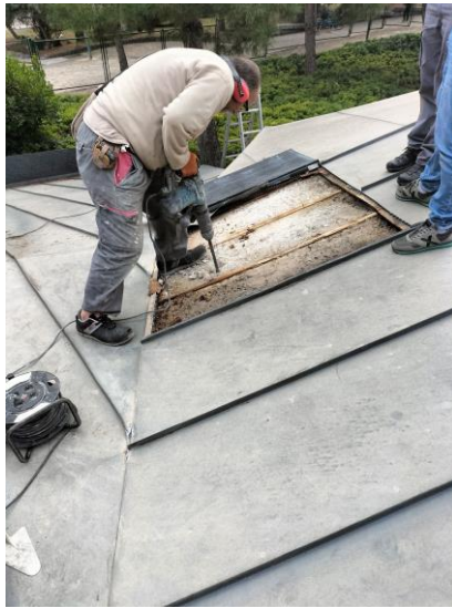
Imatges de la cala de la planxa de zinc sobre el porxo
