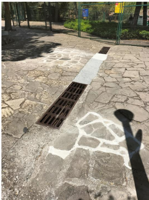
Imatges de la reparació del paviment de pedra de l'entrada al recinte de la Cripta
